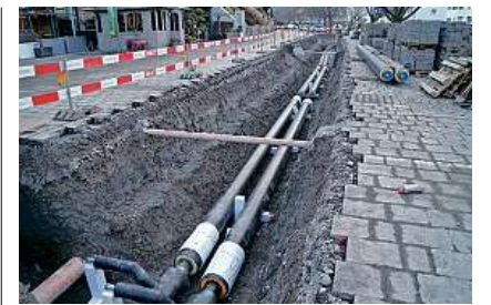
Fernwärme wird ausgebaut.
